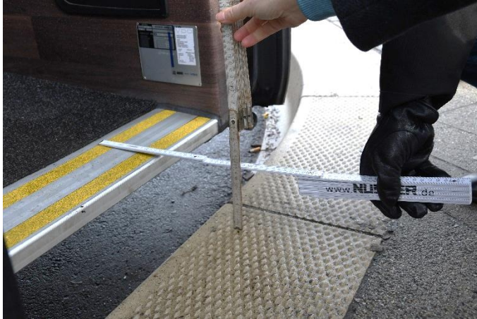
Hohe Spaltmaße / Höhenunterschiede
